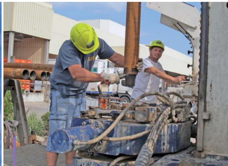
Il caricamento delle aste di perforazione e il relativo fissaggio.
