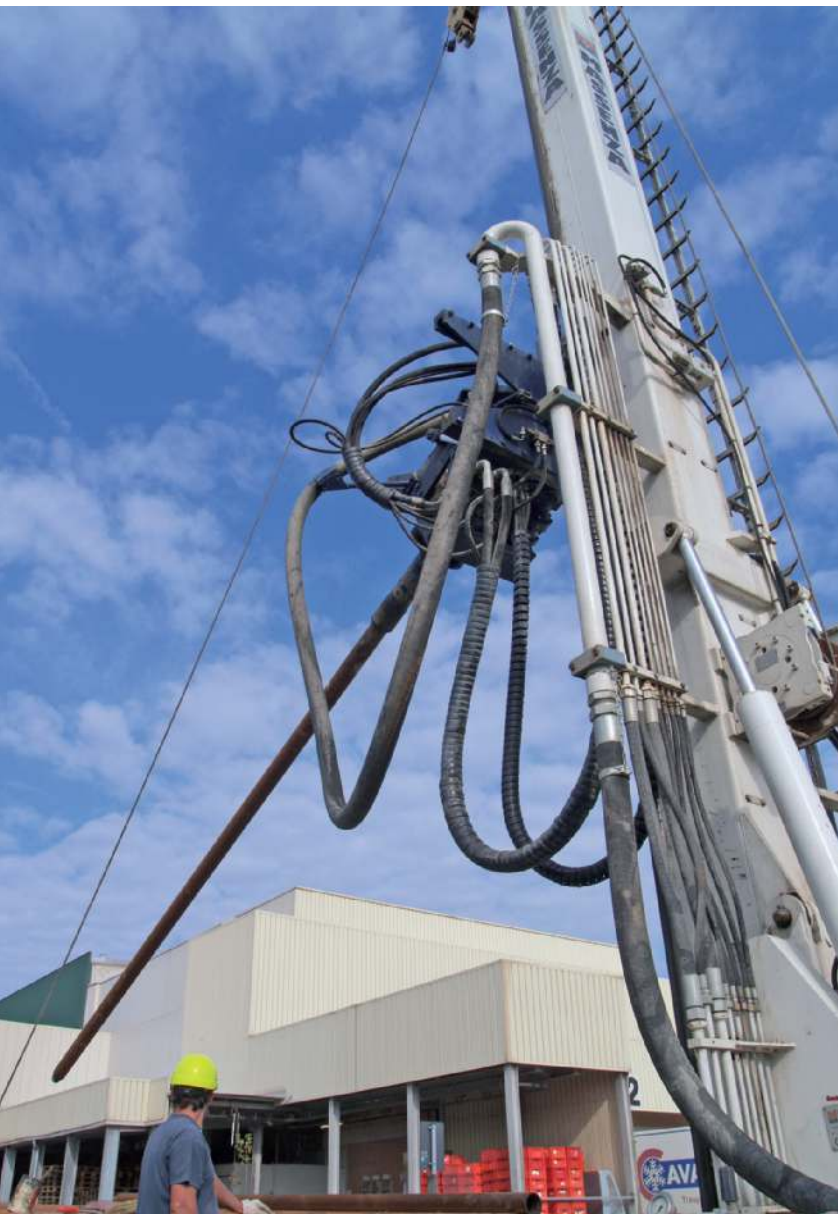
Il caricamento delle aste di perforazione e il relativo fissaggio.
