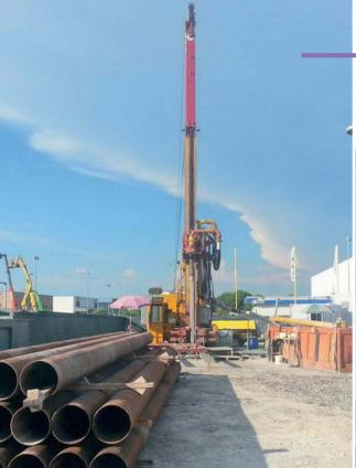
La decisione di effettuare un foro di grande diametro per inserire poi un tubo di circa un terzo ha permesso di ottenere un dreno (circa 50 m3) in grado di: colmare l'intercapedine tra il perforo e la colonna di produzione; ridurre o eliminare l'ingresso di sabbia nel pozzo; permettere una maggiore funzionalità del filtro; aumentare la permeabilità dell'acquifero; far calare le perdite di carico idraulico: stabilire una velocità di transizione graduale fra la formazione acquifera e i filtri.
