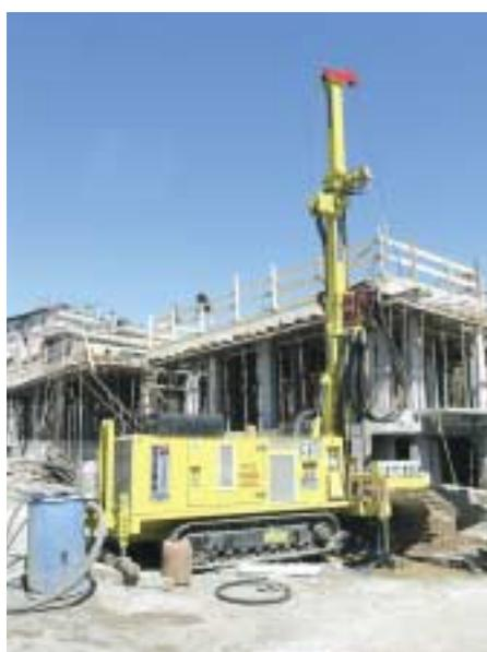
La perforatrice M.I.6: testa di rotazione: coppia max 9.630 Nm, velocità max 650 rpm, passaggio interno 50 mm
